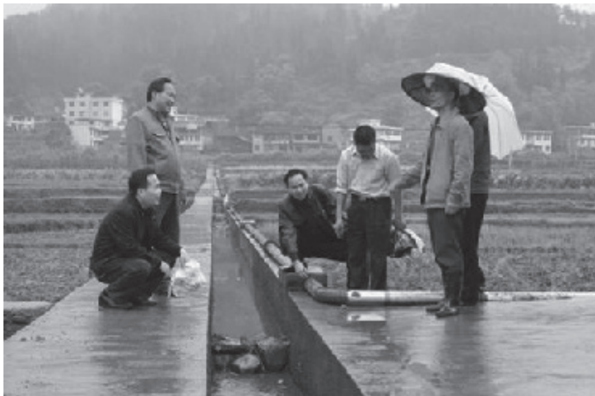
方家屯乡梅子坪机电排灌工程
