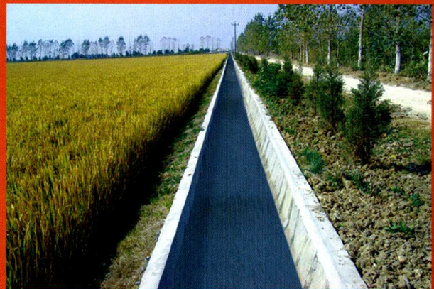
开发的防渗渠道
