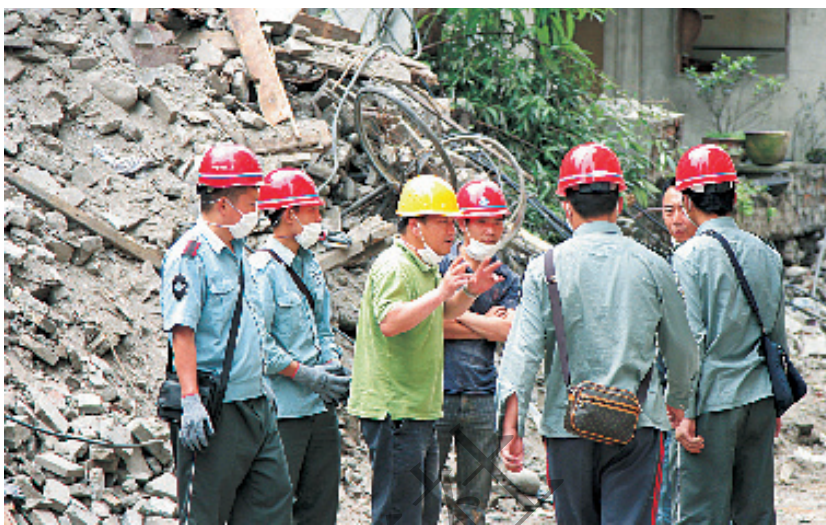
程建国局长在灾后重建拆危现场考察情况
