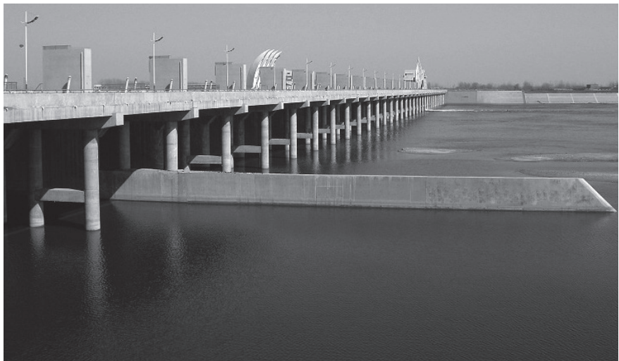
位于山东省临沂市沂河干流中下游的刘家道口水利枢纽工程,该工程对于改善生态环境、增加湿地面积发挥了重要作用。
