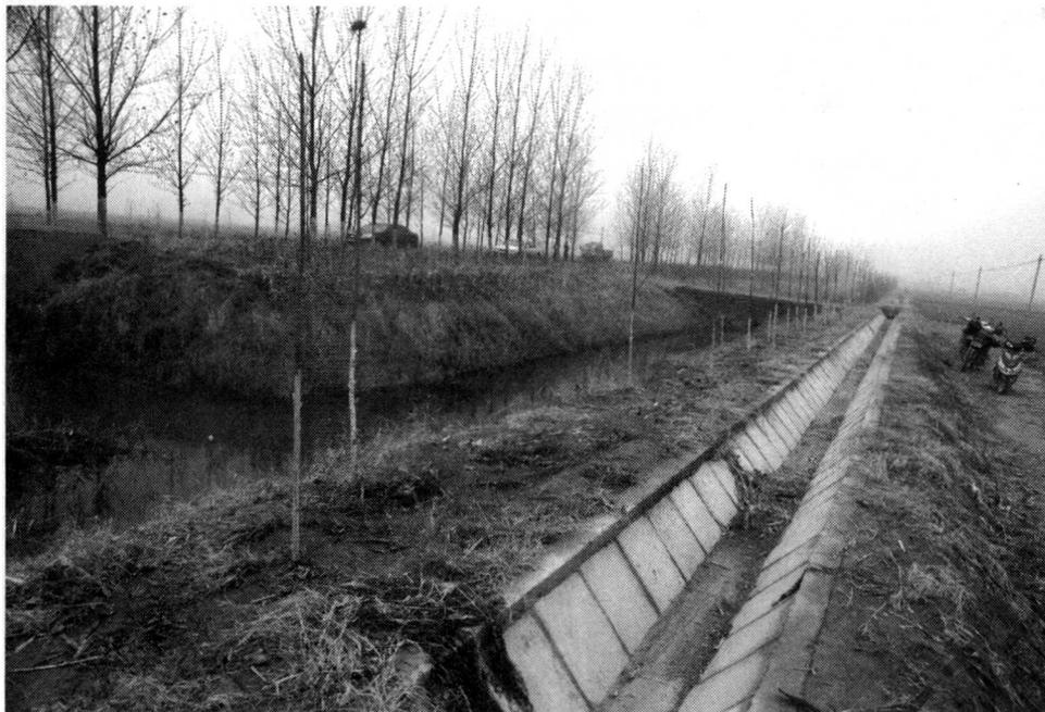
山东省阳信县小开河引黄灌区末级渠系节水改造项目，共衬砌渠道5万多米，其中：斗渠2万多米，农渠3万多米。
