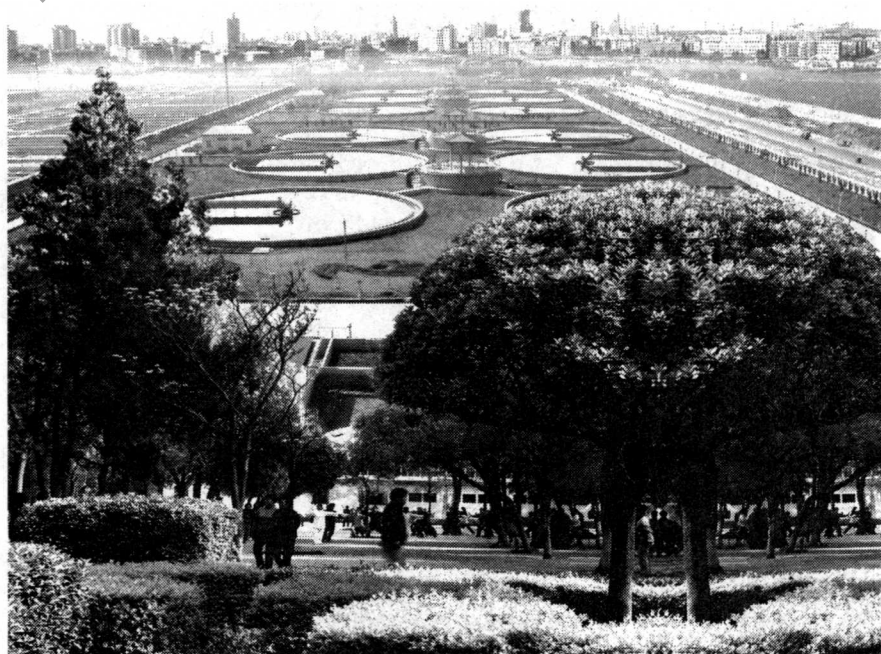
邯郸市某污水处理厂
